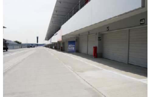
ピットロードよりピットボックスを望む
