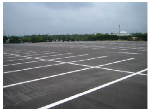
増設した正面駐車場
