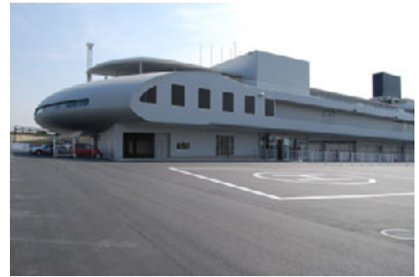
メディカルセンター(1階)と、救急ヘリポート
