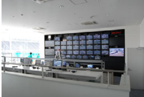
最新AV設備が設置されたコントロールルーム
