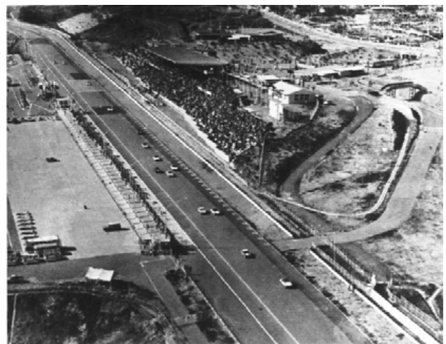
完成直後のデモンストレーションの様子
