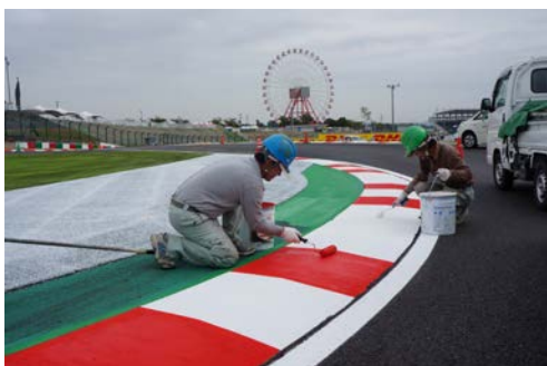
10月4日(金)に行われたレーシングコース縁石塗装の様子
