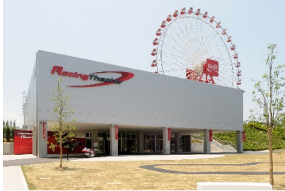
レーシングシアター外観
